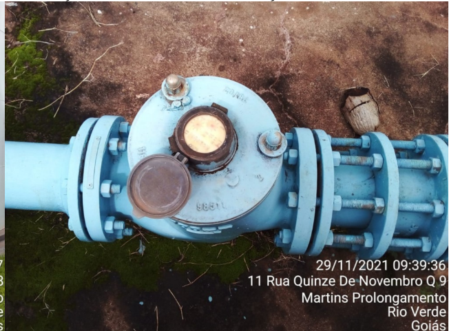
Autor: AMAE/RIO VERDE Descrição: Macromedidor de entrada do sistema.
