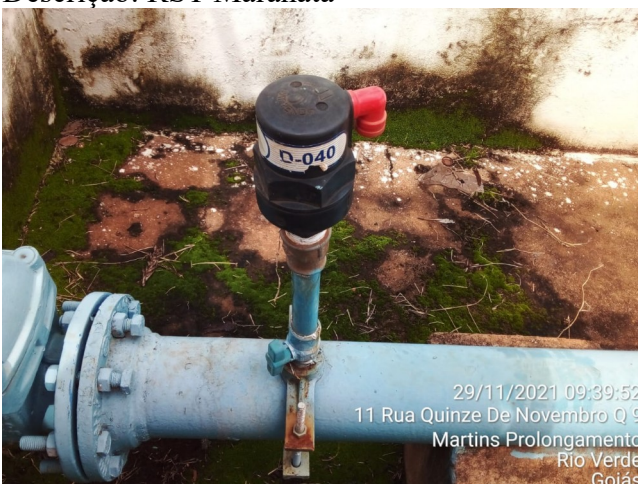
Autor: AMAE/RIO VERDE Descrição: Válvula solenóide de controle
